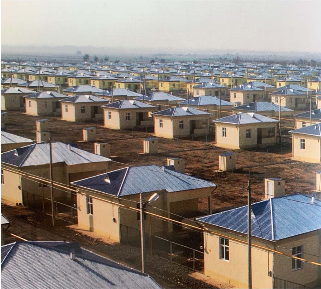
Figure 11: Les maisons construites par le gouvernement azerbaïdjanais pour les réfugiés et les expulsés des régions occupées de la République d'Azerbaïdjan (Ici: une des villages des expulsés dans la partie non-occupée de la région d'Aghdam).
